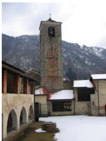
Una veduta dell'esterno
